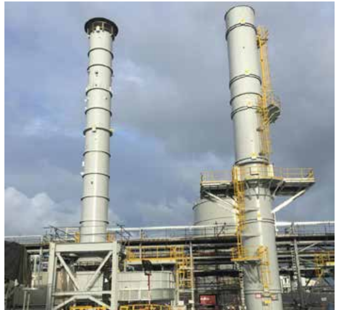
PTT LNG In-Plant Power Generation(Civil & SMP)
